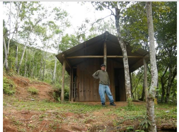
Figura 3. Construção em madeira. Foto: Maria Cristina
