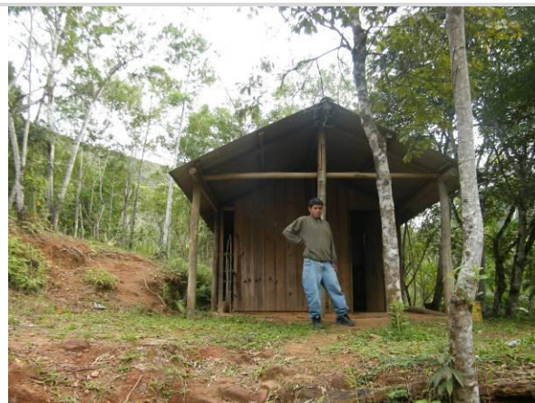
Figura 3. Construção em madeira.
