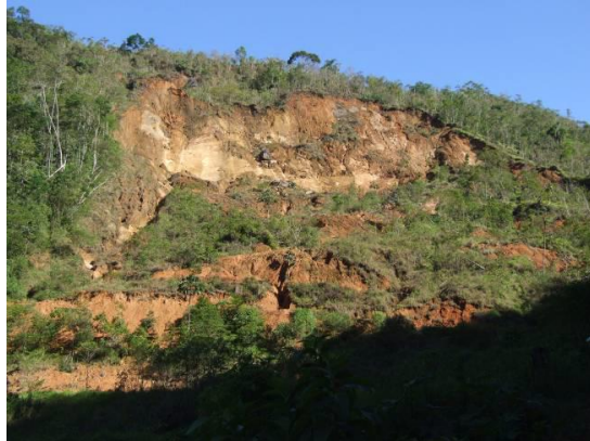
Figura 2.1.2.3.6. Movimento de massa rotacional de grande magnitude, erosão laminar e em sulcos, em talude de corte da estrada Apiaí – Iporanga. Fonte: adaptado de Fundação Florestal (2010)
