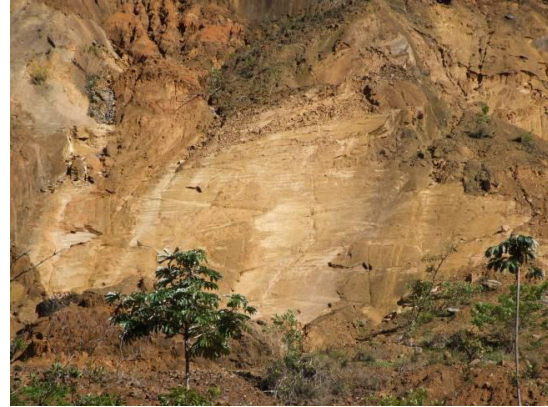
Figura 2.1.2.3.7. Exposição do Filito da Formação Mina de Furnas decorrente do movimento de massa rotacional. Fonte: adaptado de Fundação Florestal (2010)
